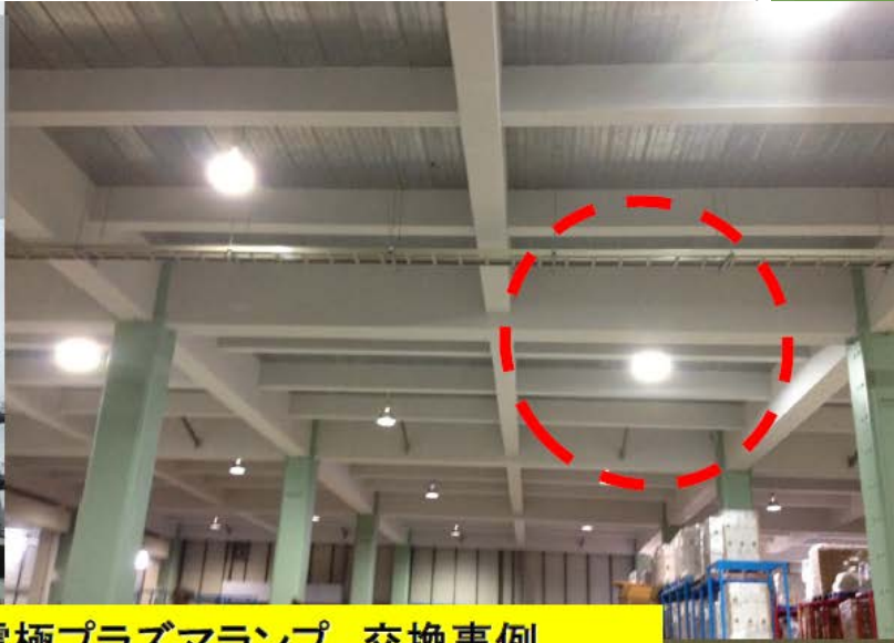
A社様 葛西倉庫 無電極プラズマランプ 交換事例
