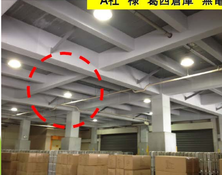
A社様 葛西倉庫 無電極プラズマランプ 交換事例
