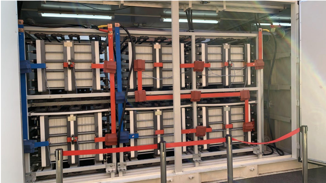
レドックス・フロー電池 セルスタック写真
