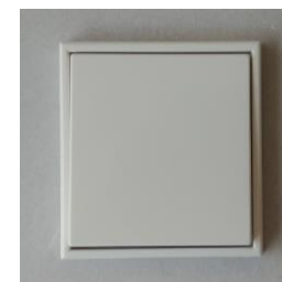
⑤インサートを埋め込みボックスに固定後、プレートとカバーを装着して完了です
