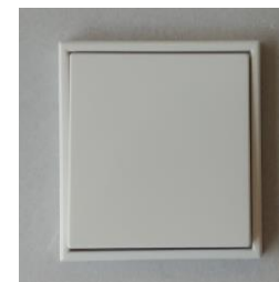
⑧フレームとカバーを装着したら完了です
