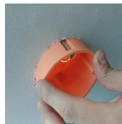
③プラスチックボックスを挿入 (*固定用ピースの位置が上下になるように挿入)
