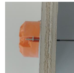
④ドライバーで固定用ピースを締めます (*写真は上から見たイメージ)
