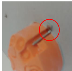
⑤固定後の状態を壁の裏側から見たイメージ (*石膏版の後部が壊れた場合は固定ににくい可能性がある)
